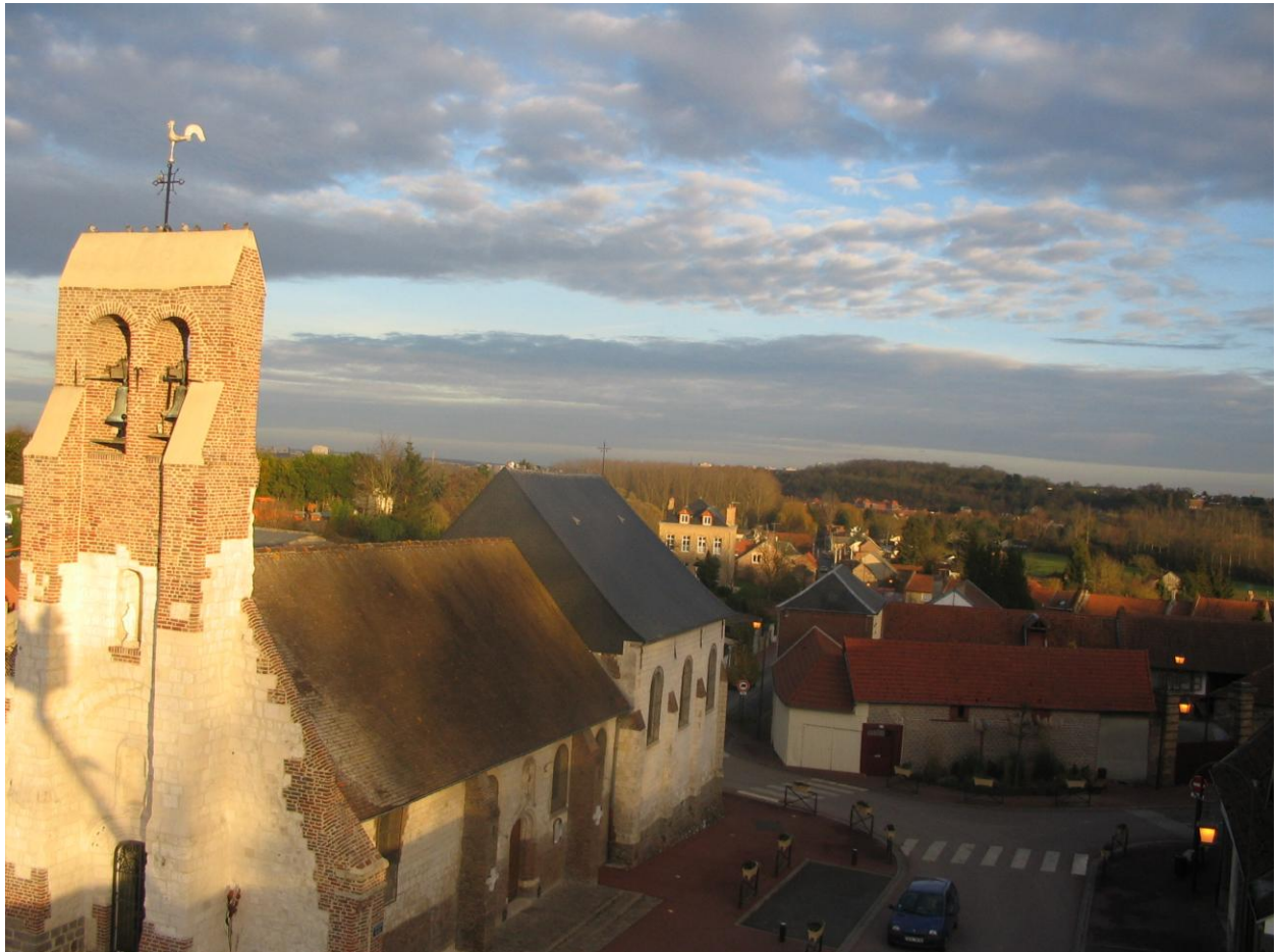
Vue depuis une nacelle lors d'une intervention sur l'éclairage public.
