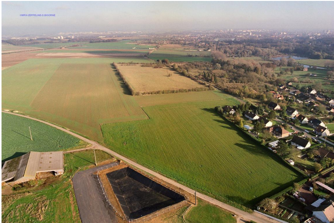
Photo de la parcelle avant la construction du groupe scolaire
